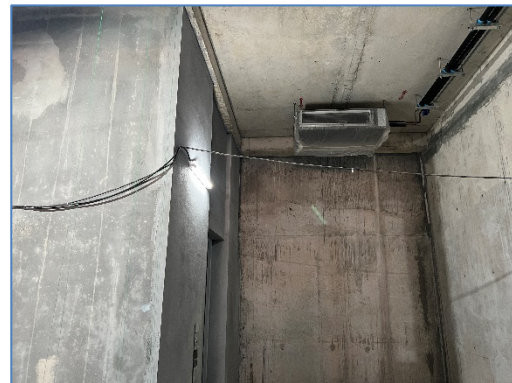
ภาพถ่ายที่ 2.1-26 ที่แขวนสายไฟฟ้า
