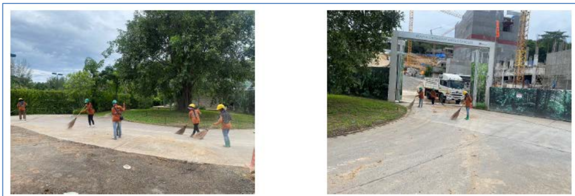
ภาพถ่ายที่ 2.1-5 จุดล้างล้อรถก่อนออกจากโครงการ การฉีดพรมน้ำ และล้างทำความสะอาดบริเวณทางเข้า-ออกโครงการ
