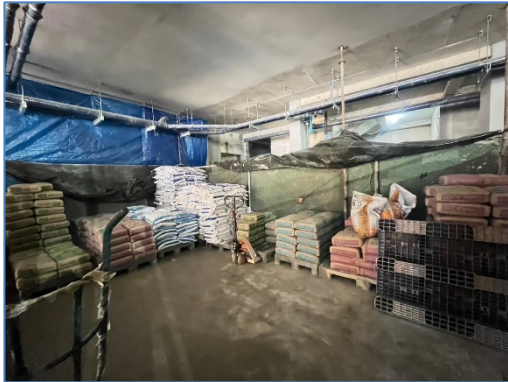
ภาพถ่ายที่ 2.1-3 โรงเก็บวัสดุอุปกรณ์ปูนซีเมนต์ที่ มิดชิด
