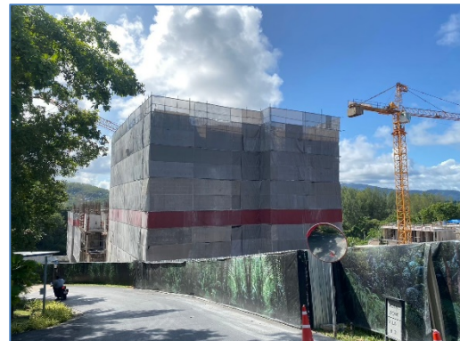
ภาพถ่ายที่ 2.1-2 รั้วทึบกันรอบพื้นที่โครงการพร้อมตาข่ายกันรอบอาคาร
