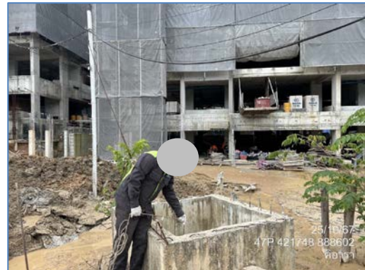
บ่อพักน้ำก่อนระบายออก
