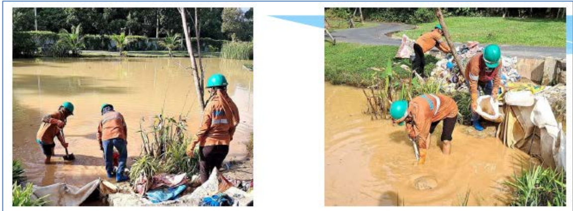
ภาพถ่ายที่ 2.1-14 ป่อดักตะกอนในโครงการพร้อมพักน้ำก่อนระบายออก และการทำความสะอาดอ่างเก็บน้ำบริเวณพื้นที่ภาระจ่ายอมด้านทิศใต้ของพื้นที่โครงการ
